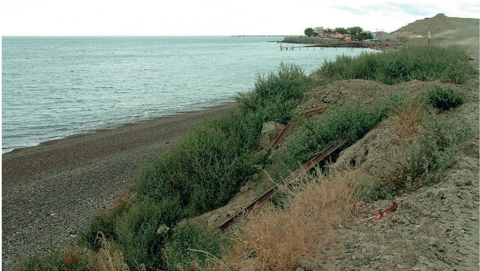
Figura 9. Erosión marina mostrando la caída al mar de las vías por donde corría el ferrocarril hasta el año 1958. Cabe señalar que esas vías en la década del cuarenta se encontraban a unos 75 metros de la línea de costa. Comodoro Rivadavia. Provincia de Chubut. 2006
